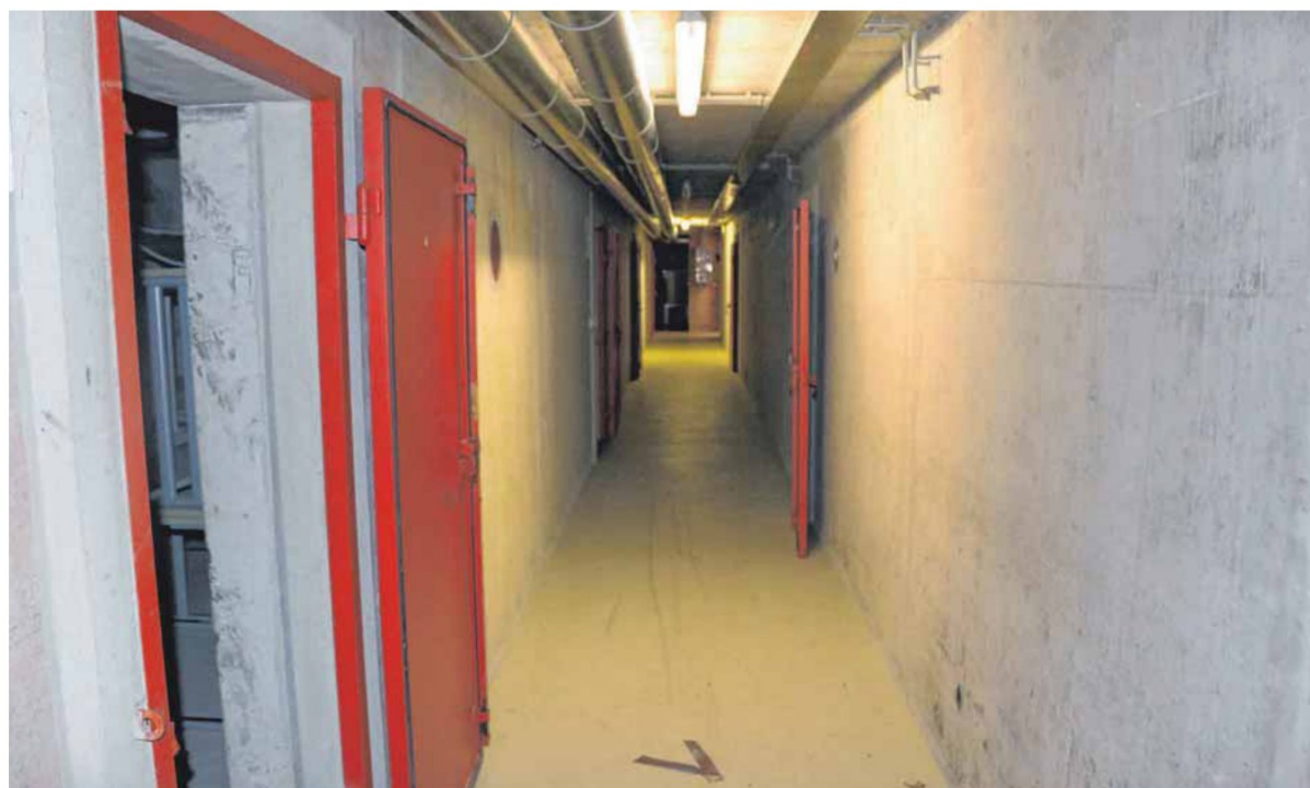
In den beiden Bunkern unter der Geschwister-Scholl-Schule gibt es jeweils mehrere Räume.
