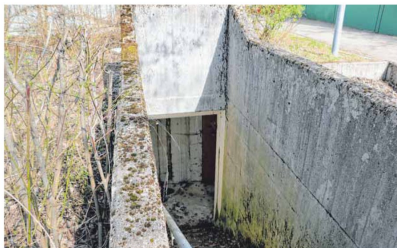
Ein Zugang zum Bunker unter Haus D befindet sich hinter der Kreissporthalle.
